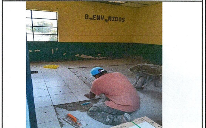
Foto 4: Colocación de piso en aula de modulo II
