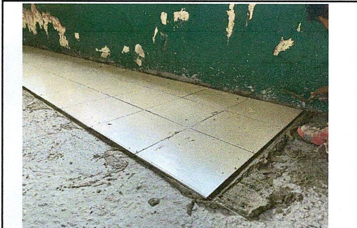
Foto 3: Colocación de piso en aula de modulo II
