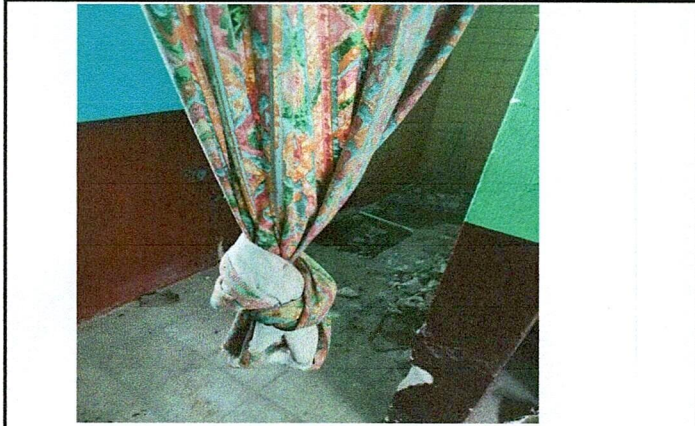
Foto 1: Levantado de piso en aula modulo I
